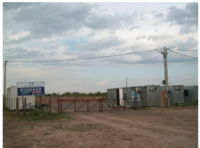
Figura 76. Vista del predio donde se radicará la Central Termoeléctrica
