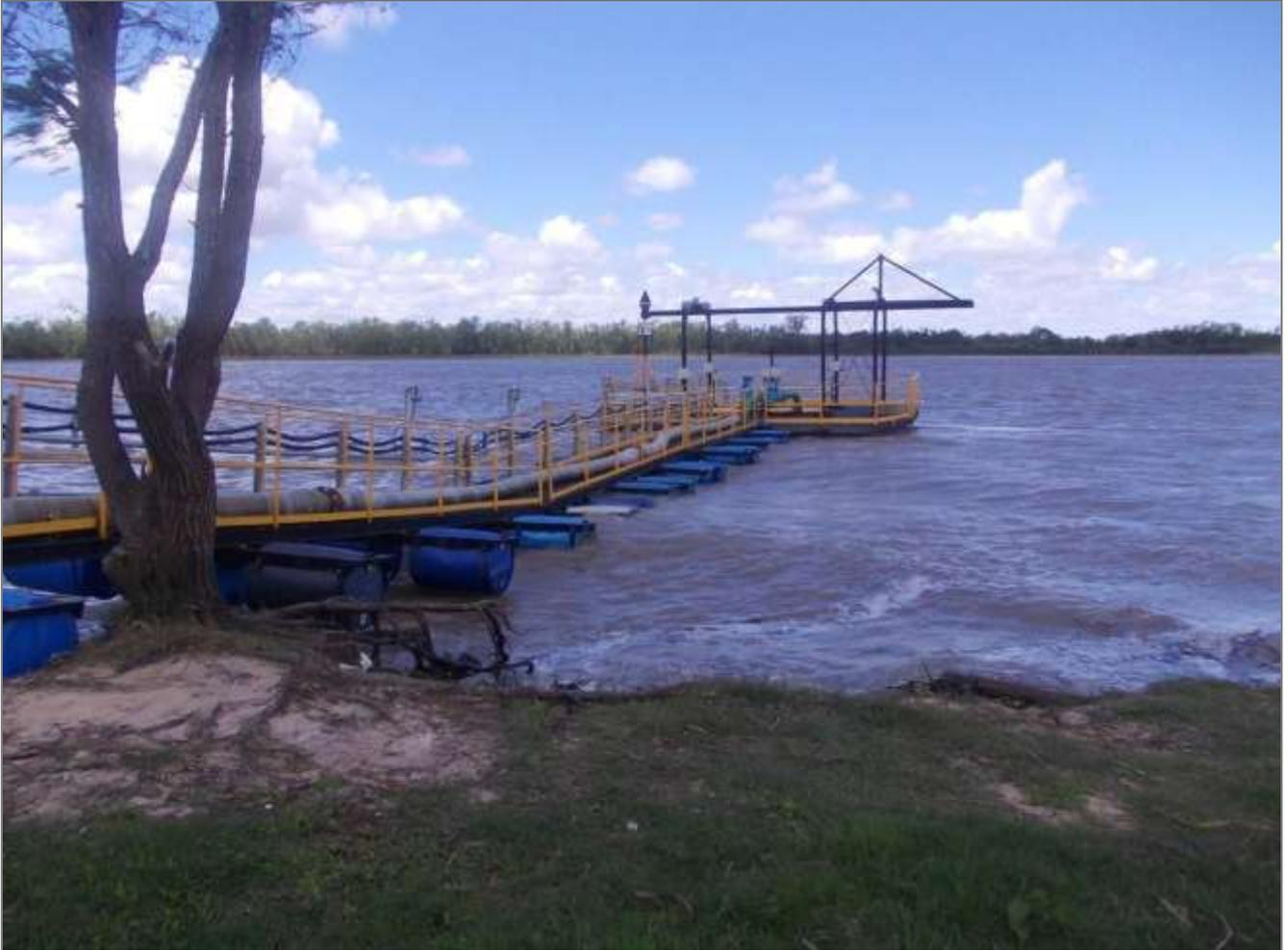
**Figura 112.** Pontón flotante del acueducto provisorio.
