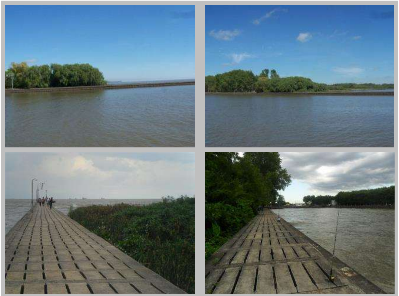
Figura 3. Imágenes de la zona de emplazamiento de la futura obra de toma de la CTEB. Arriba: Fotos tomadas desde el agua. Abajo: Fotos tomadas desde la escollera SO.
